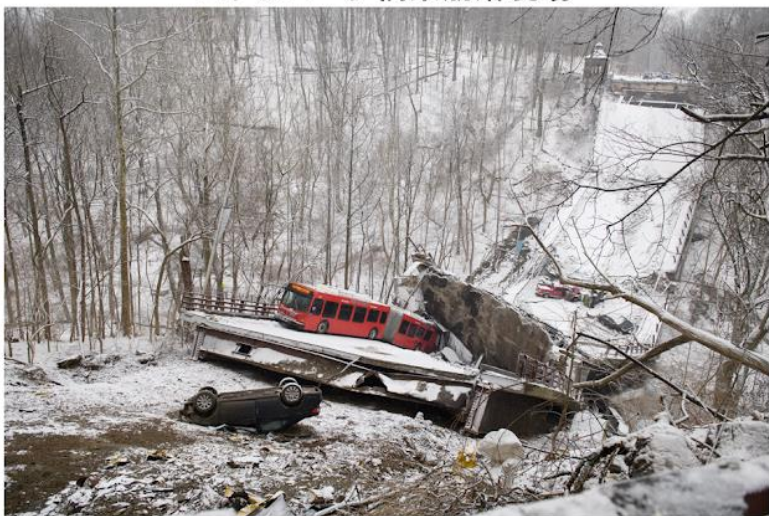
ピッツバーグ橋梁崩落現場
