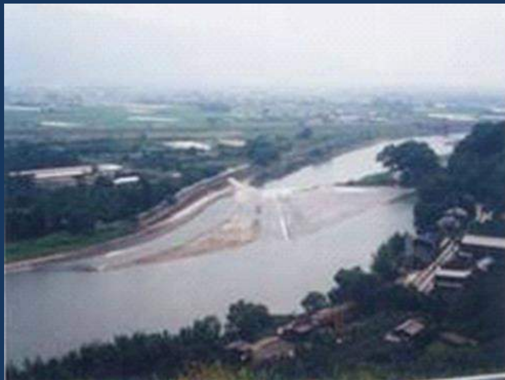
筑後川 山田堰（福岡県 朝倉）
