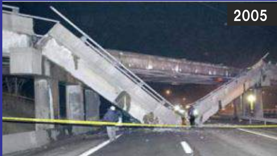
I-70コンクリート跨道橋の崩壊 (米:ペンシルバニア州)
