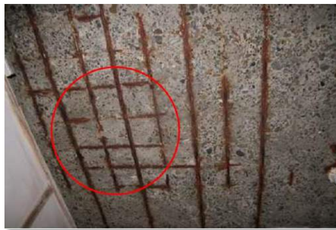
コンクリートの剥落・鉄筋の露出
