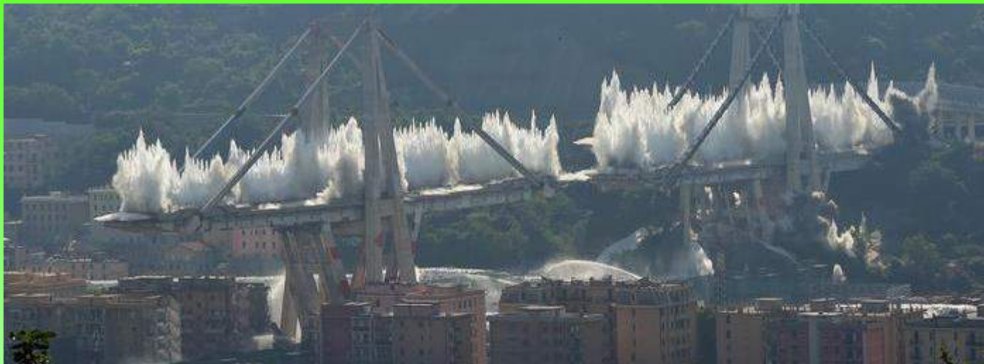
旧ポルチェベラ高架橋の取り壊し
