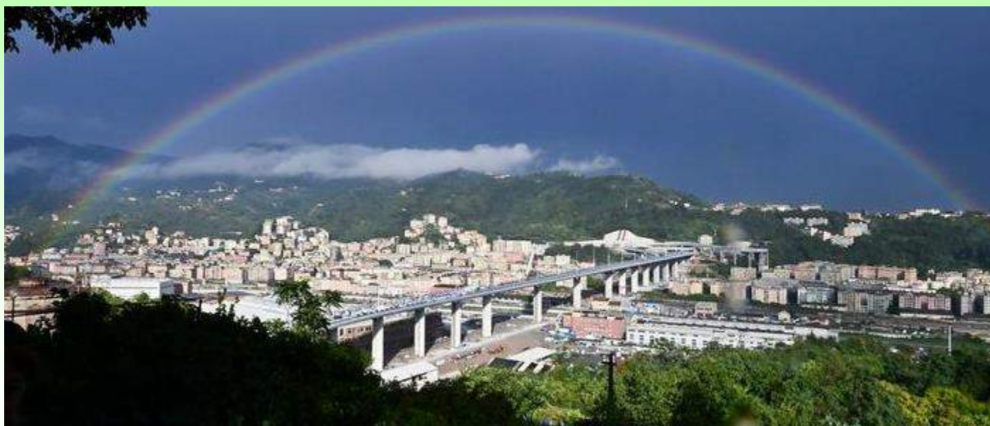
新ポルチェベラ高架橋(2020)
