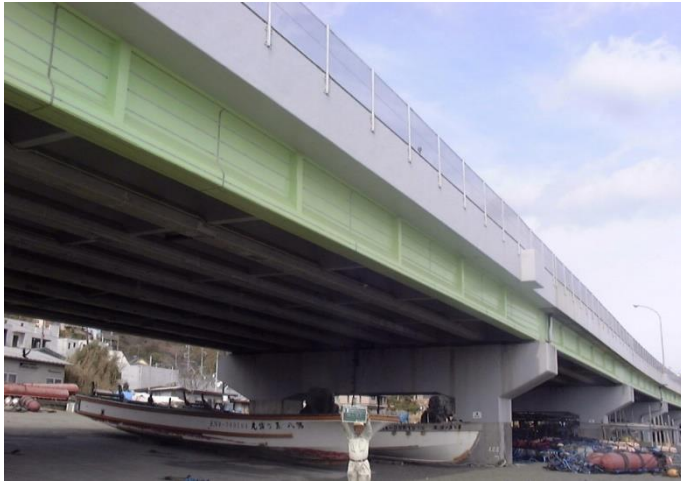
橋梁構造物への適用事例
