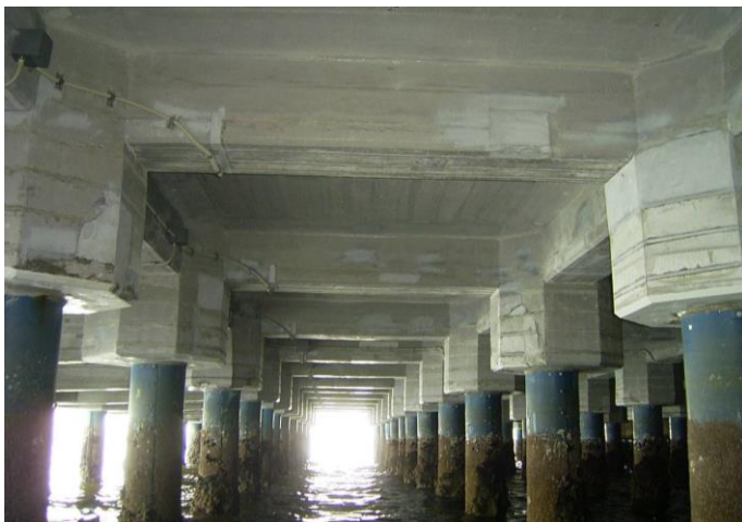
栈橋構造物への適用事例
