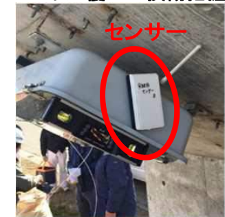
レーダーを利用した トンネル覆工の損傷把握
