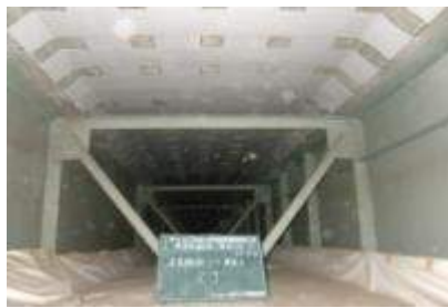
炭素繊維シートの貼り付け
