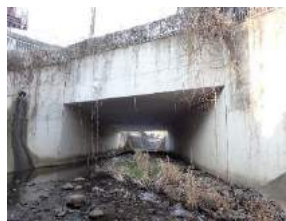
▲水路ボックス
