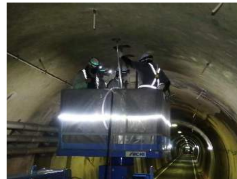
＜裏込め注入の施工状況＞
