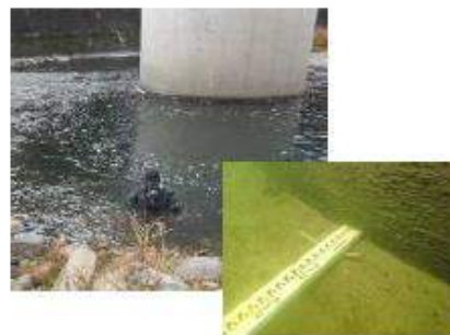
潜水調査による河床洗掘の把握
