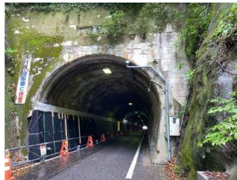
＜R4.4.26仁方隧道の状況＞
