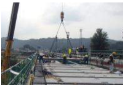
プレキャスト床版による 打ち替え
