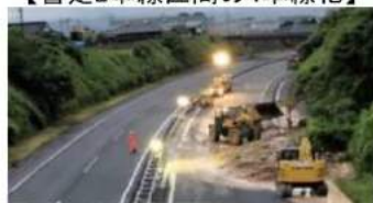
被害のない2車線を活用し、交通機能確保
