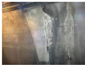
▲トンネル目地部
