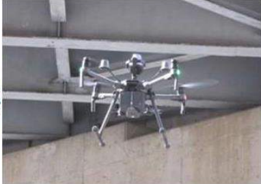
(新技術：ドローンによる点検)
