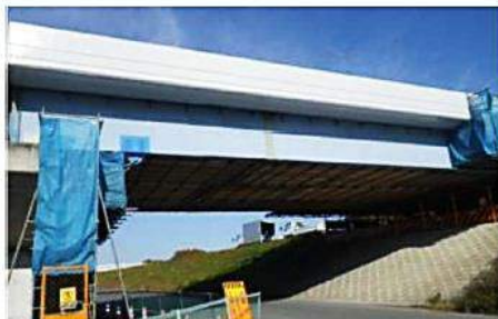
橋梁点検と補修工事で 足場を共有
