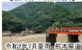
令和2年7月豪雨 熊本県道
