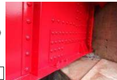
桁端部の当て板・塗装
