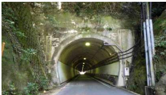
＜仁方隧道の状況＞
