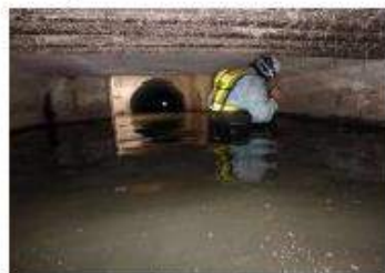
滞水した溝橋内部の目視点検
