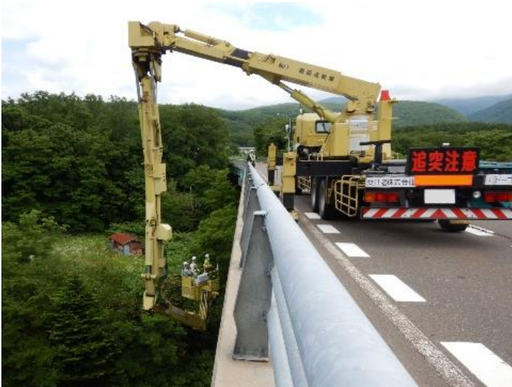
橋梁点検車による点検
