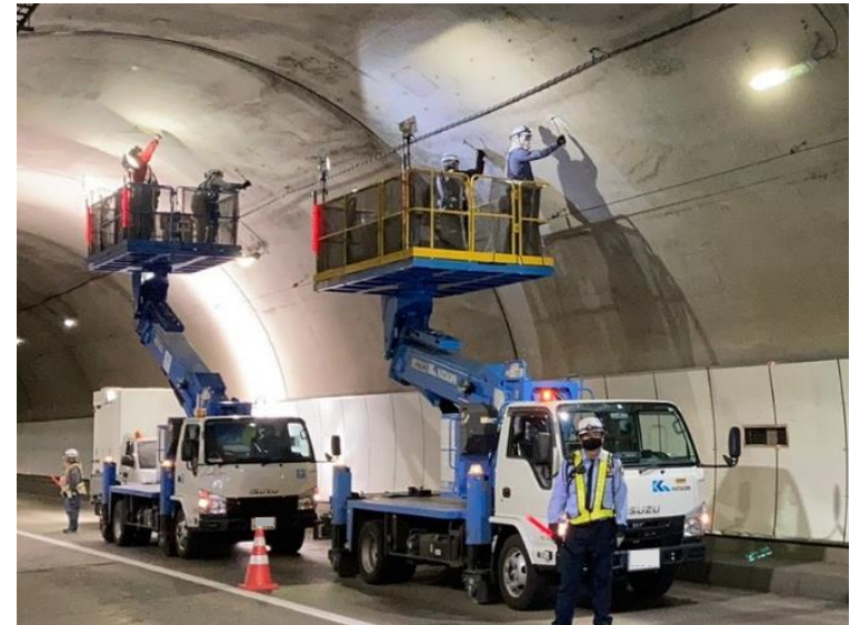
高所作業車によるトンネル点検
