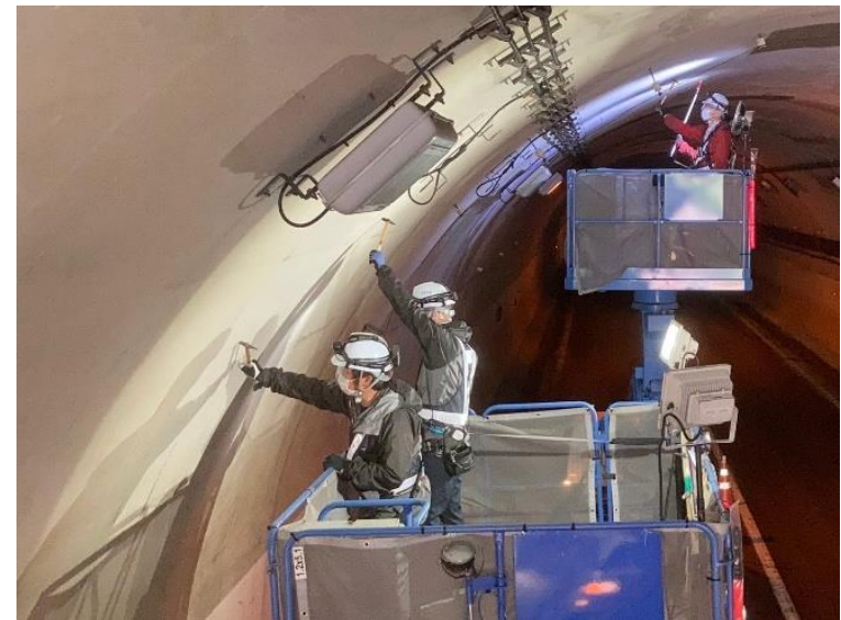
近接目視によるトンネル点検
