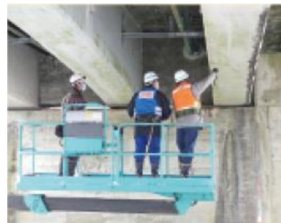
白老町戸田町長(右)に、橋梁の状況を説明
