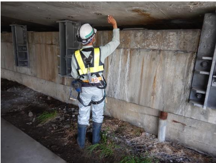
近接目視による橋梁点検
