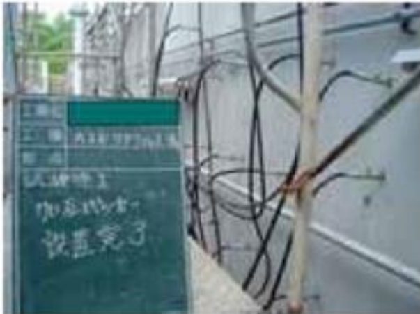
擁壁のASR補修事例
