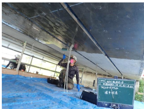
亜硝酸リチウム表面含浸材塗布
