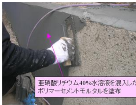
亜硝酸リチウムを混入した ポリマーセメントモルタルを塗布
