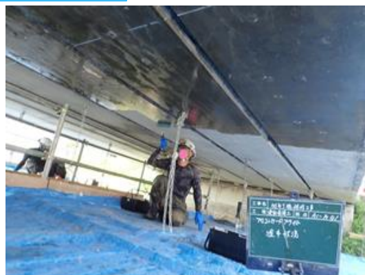
亜硝酸リチウム系表面含浸材塗布
