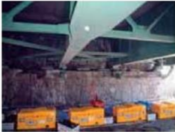
橋台のASR補修事例
