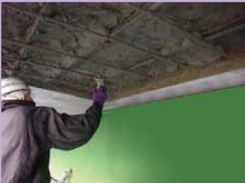
④断面修復工法 『リハビリ断面修復工法』 NETIS:CG-220003-A
