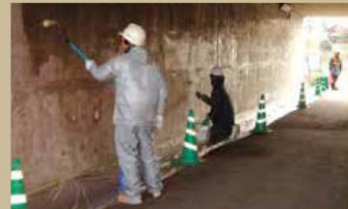
⑥表面含浸工法 『プロコンガードシステム』 NETIS:CG-150013-A 『プロコンガードシステムS』 『プロコンガードシステムHP』
