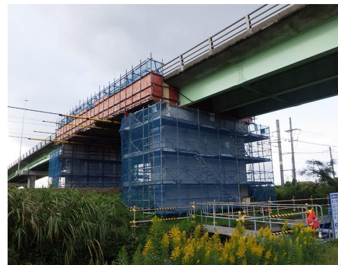
交差条件によりアプローチ困難な場合に
