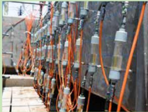
②簡易型高圧注入 『リハビリカプセル工法』 NETIS:CG-120005-VR
