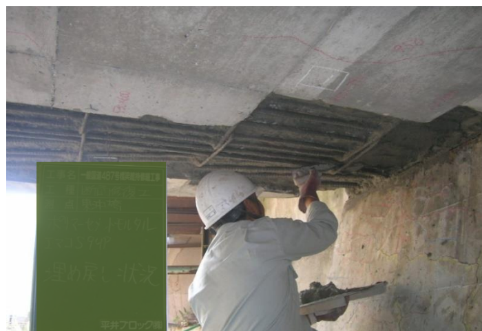
部分断面修復工
