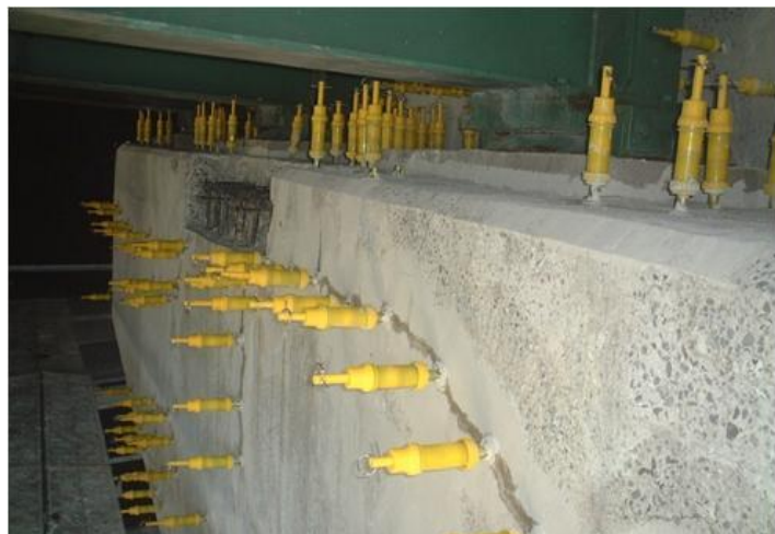
ひび割れ注入工
