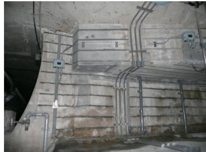
1. 鉄筋の腐食と電気防食
