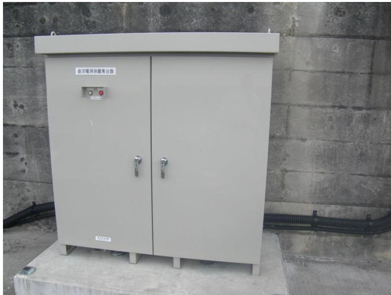
8回路用直流電源装置の例
