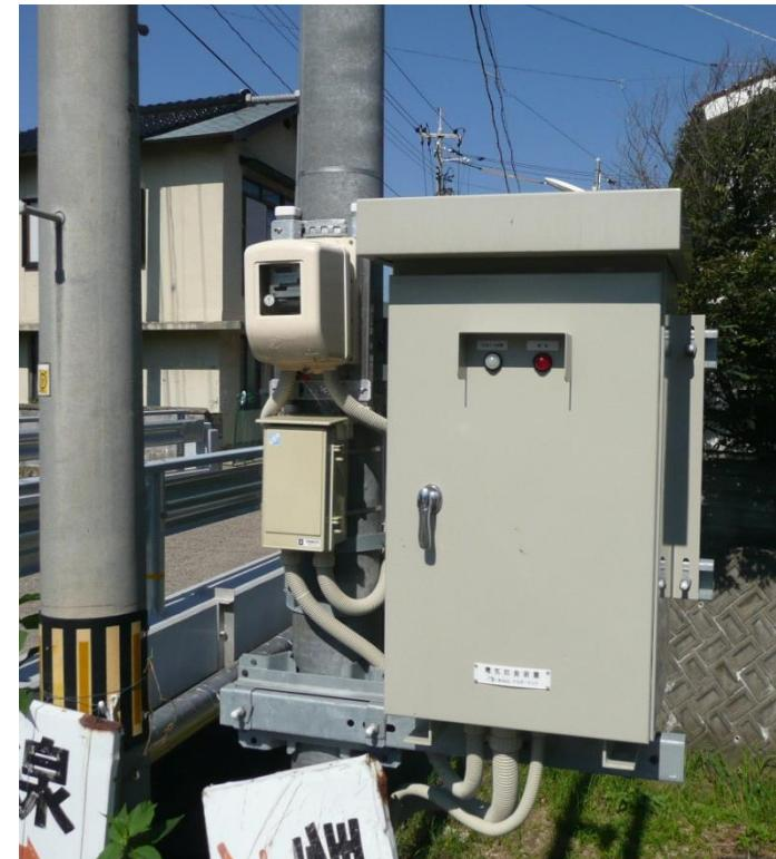
1回路用直流電源装置の例
