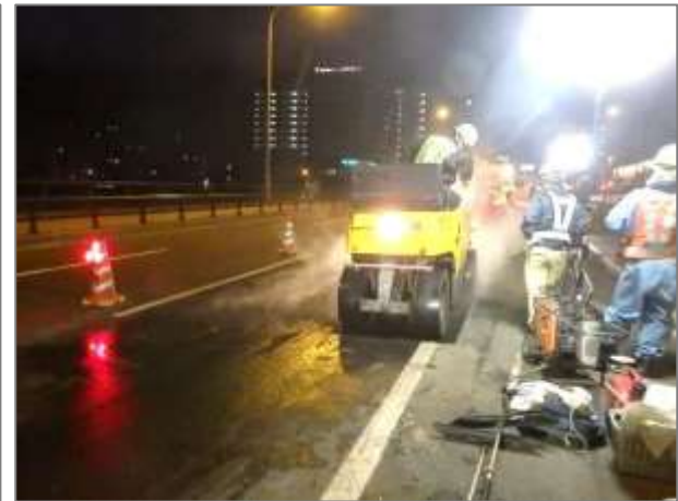
アスファルト舗設
