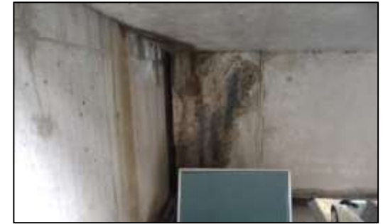
主桁の損傷
