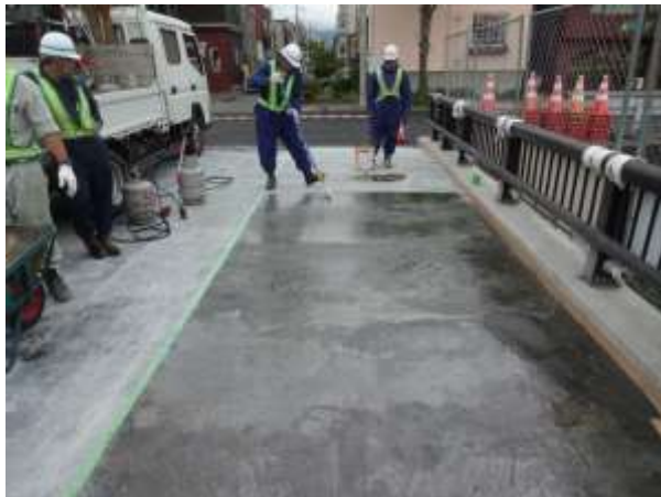
プライマーの塗布
