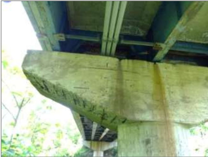
被りコンクリートの剥落
