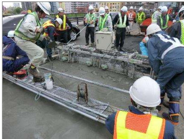
J-ティフコムの敷均し
