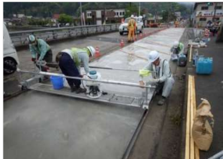
連続打設とシート養生
