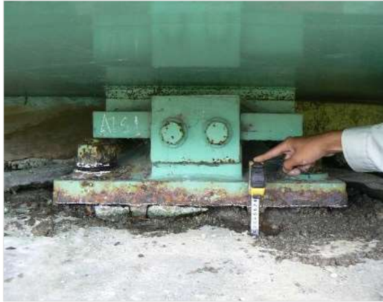
支承と沓座の劣化
