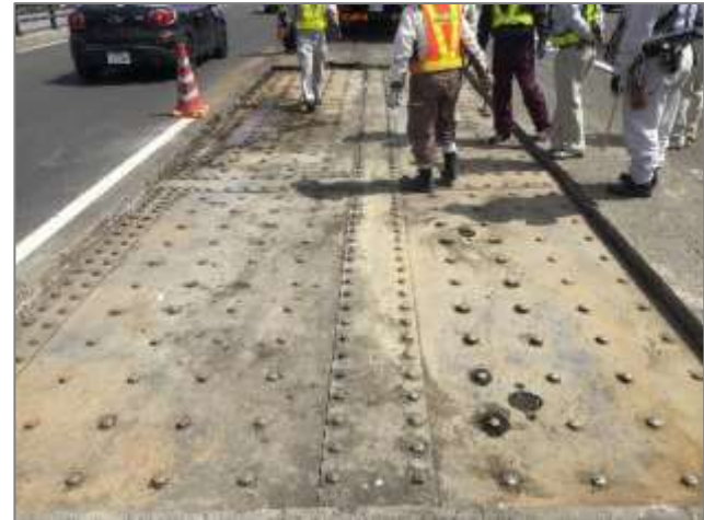
舗装の撤去完了
