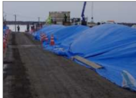
J-ティフコム打ち込み後のジェットヒーターによる給熱養生
