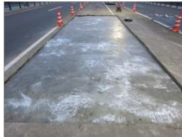
J-ティフコムの施工完了
