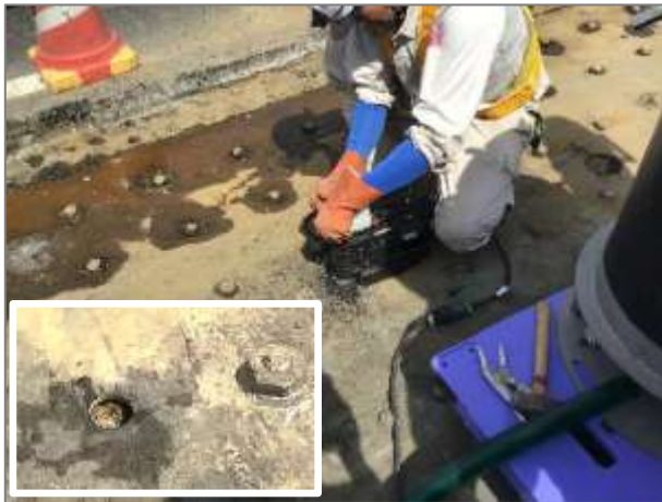
注入口の削孔
