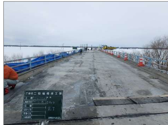
J-ティフコムの施工完了
