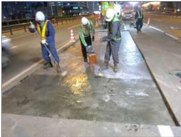
プライマーの塗布
