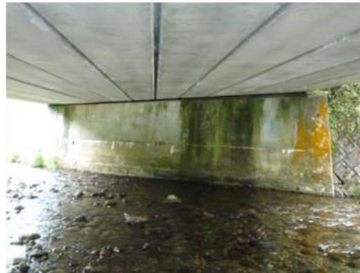
橋台前面の汚れ
