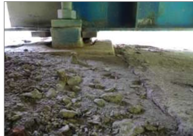
橋脚天端面の劣化損傷
