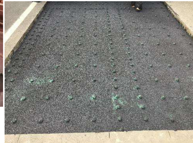
接着層の完成
