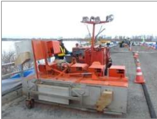
路面ヒーターによる施工前の熱養生
