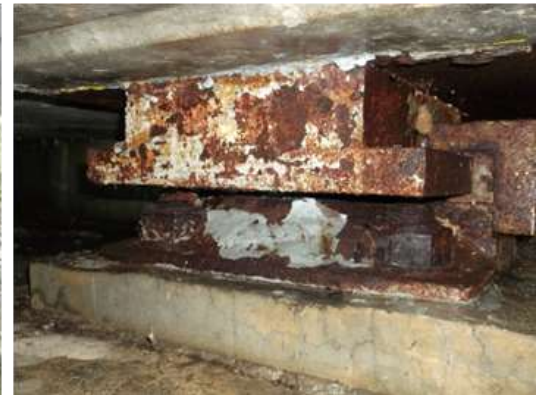
支承部の腐食
