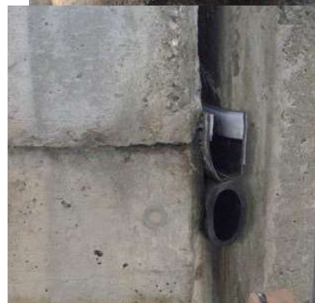
ゴム製排水装置遊間30mm
