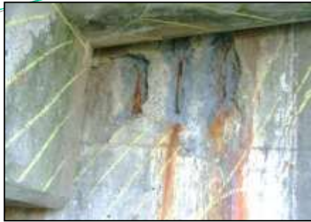
パラペットの損傷 付属物 0%
