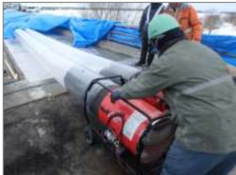
J-ティフコム打ち込み後のジェットヒーターによる給熱養生
