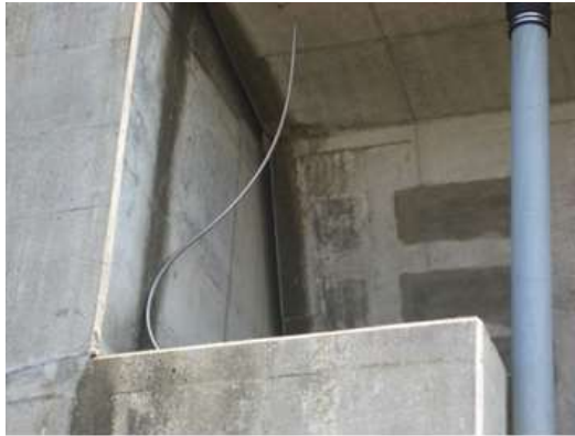
主桁やパラペットの汚れ
