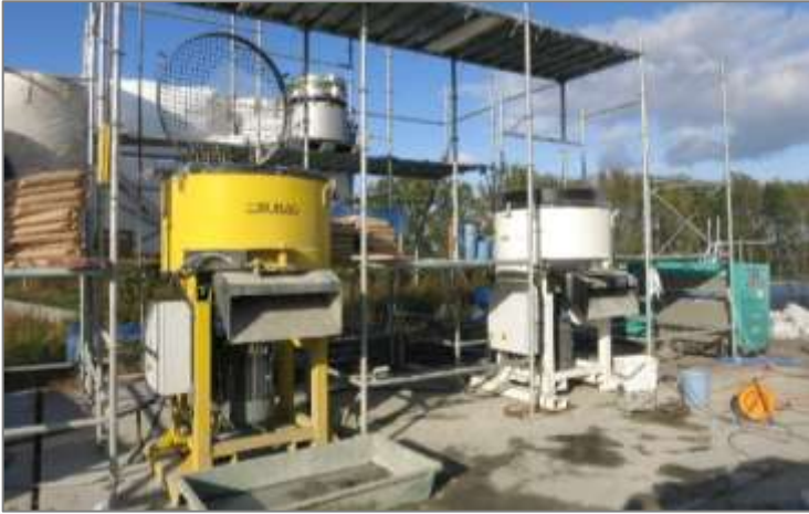
J-ティフコム の 施工
