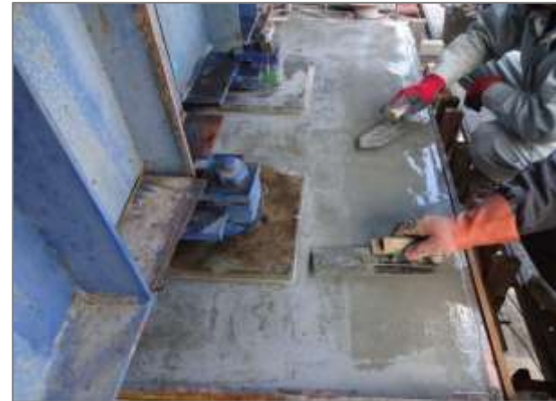
コテによる表面仕上げ
