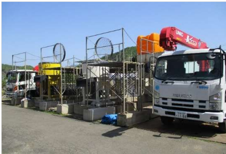
現場での練り混ぜ状況
