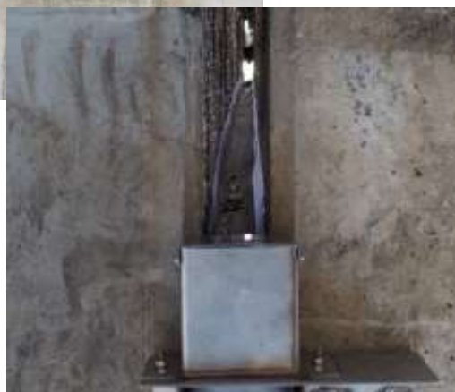
ゴム製排水装置遊間50mm
