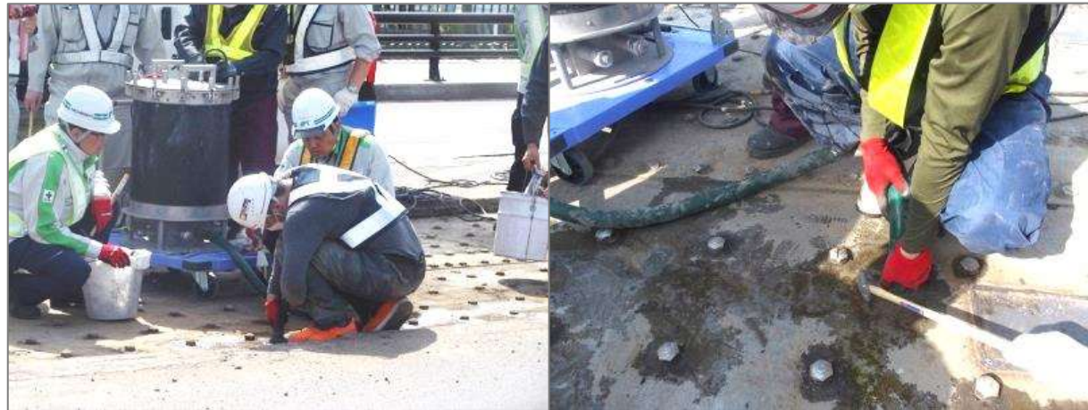
圧送タンクを使用したJ-ティフコムの圧入状況
