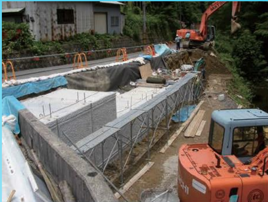
施工中(通路確保)
