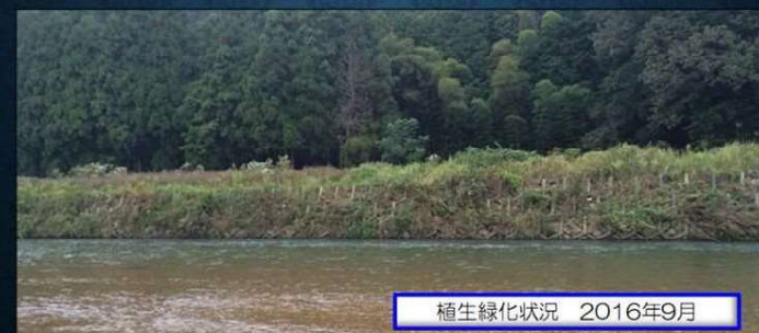
兵庫県 国交省近畿地整 河川護岸工事（NETIS試行施工2009年）
