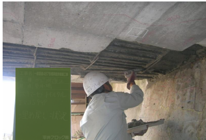
部分断面修復工
