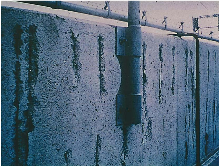
壁高欄のコンクリートはく落
