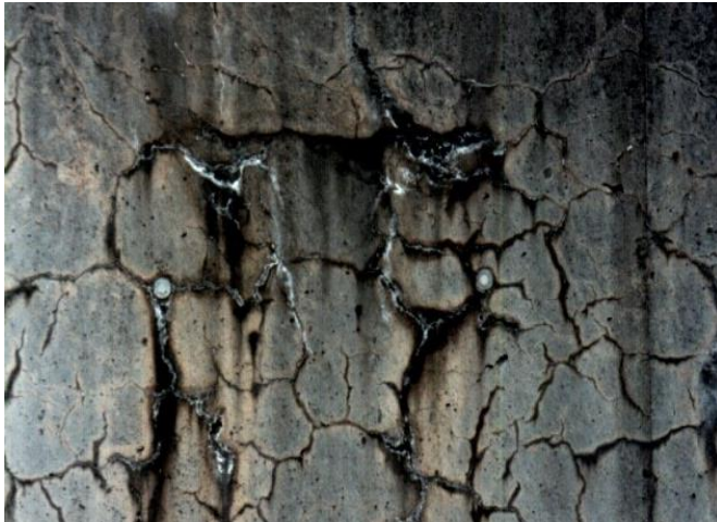
コンクリート表面の変状
