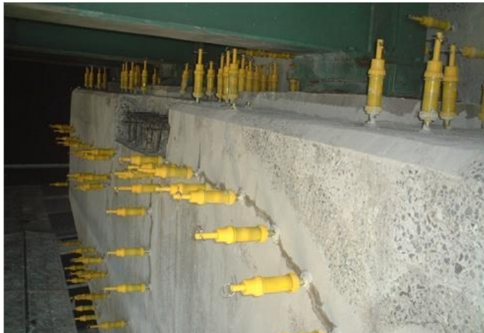
ひび割れ注入工
