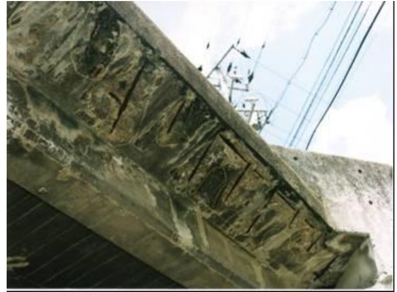
張出し床版下面の鉄筋露出
