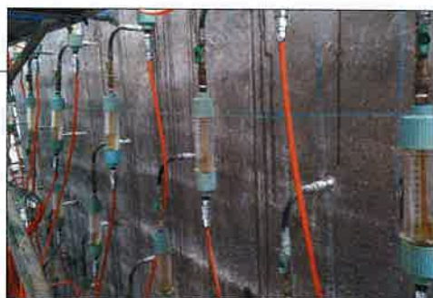
リハビリカプセル工法による港湾構造物のASR・塩害補修状況
