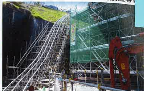
▲橋脚耐震補強工事にて橋脚脇にレール設置
