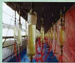
リハビリカプセル工法によるRC床版の塩害補修
