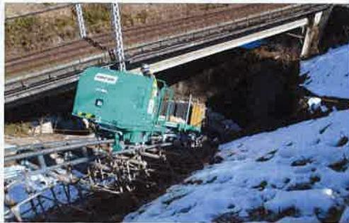
▲0.14m 2 バックホウ等の資機材を運搬
