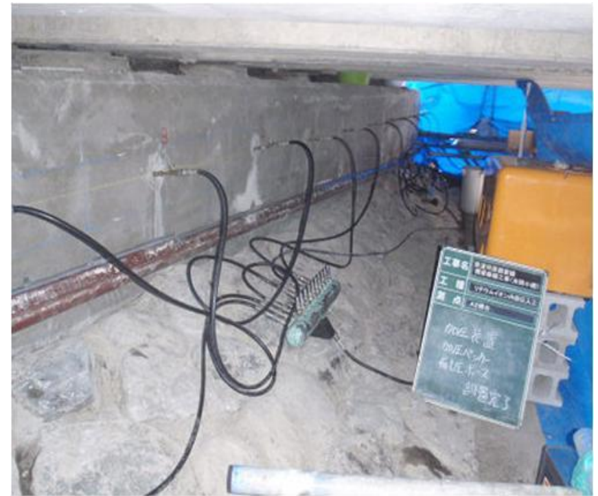
亜硝酸リチウム内部圧入工法
