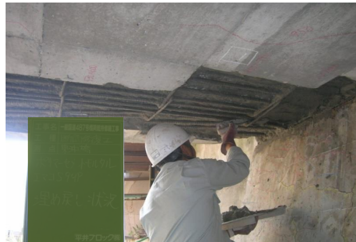
部分断面修復工
