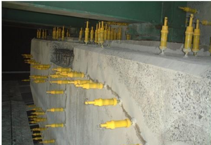
ひび割れ注入工
