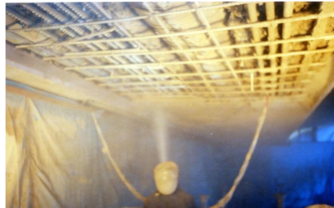
全断面修復工法
