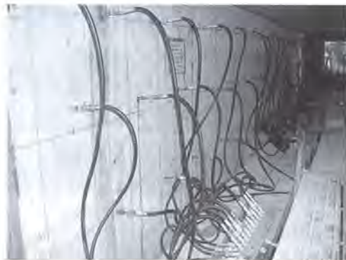
写真2 内部圧入工の施工状況
