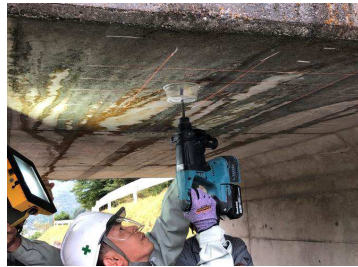
ドリルによる削孔 粉体採取状況
