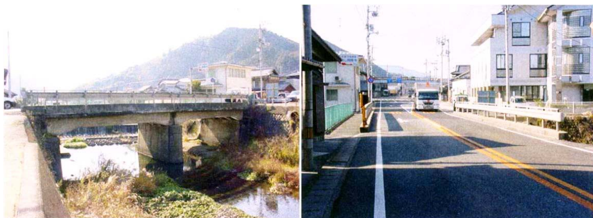
①国道11号 ミョウノタニガワ 妙ノ谷川橋 昭和7年(1932年)架設
