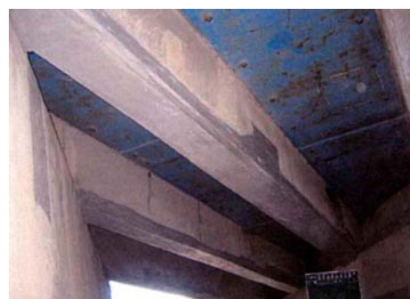
補修後の状況
