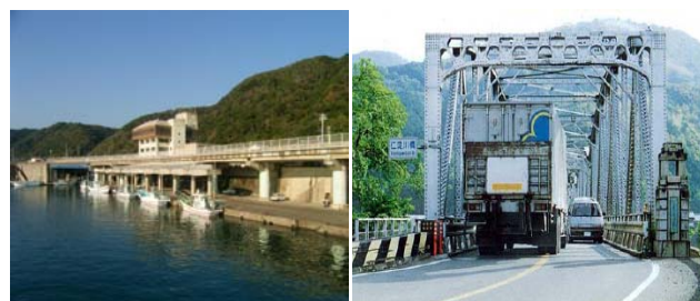
海岸からの塩分の影響(左)、大型車交通の繰返し荷重(右)
