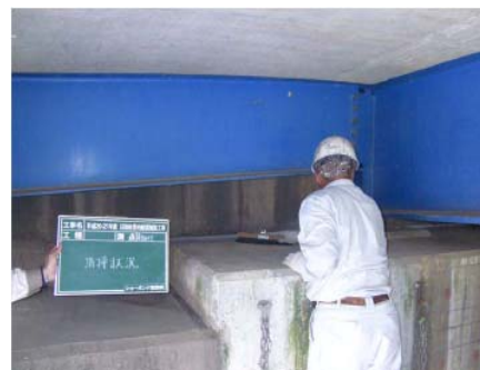
支承周りの清掃
