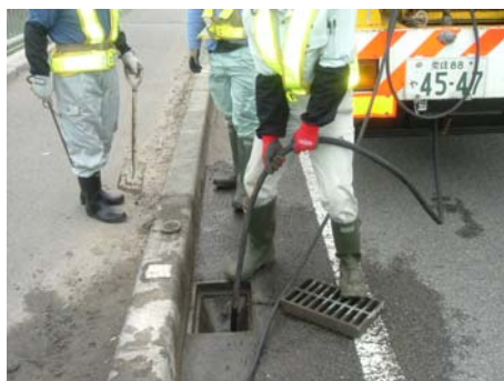
排水柵の清掃
