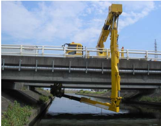
点検車による定期点検
