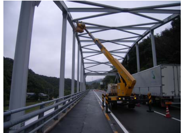
高所作業車による定期点検
