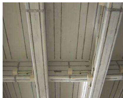
電気防食工法
