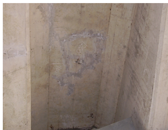
補修後(ひび割れ注入)
