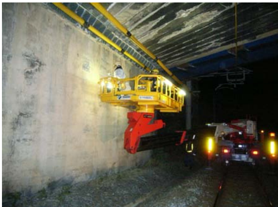
軌陸車による跨線橋の定期点検
