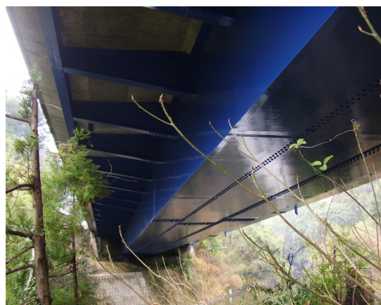
補修後(塗替え塗装)
