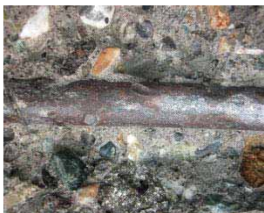
(a) RC 床版橋
