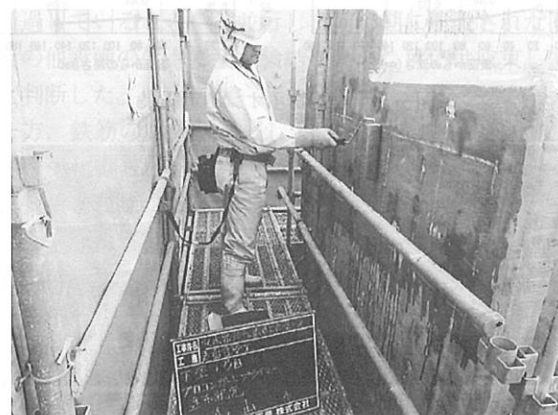
写真-8 表面含浸工
