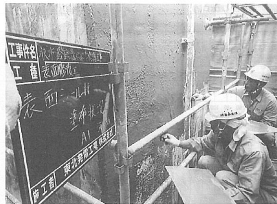
写真-6 表面修復工
