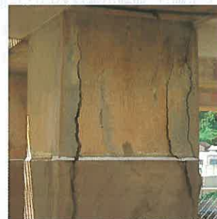
写真 5 柱 A 境界部
