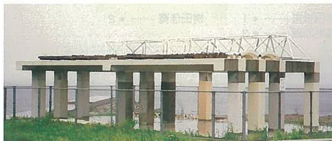
写真 1 実構造物の設置状況
