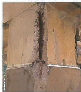
写真 4 柱 A の鉄筋外観
