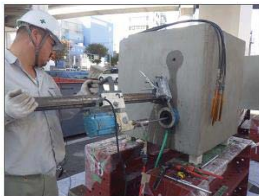
写真-3 内部圧入孔の削孔状況
