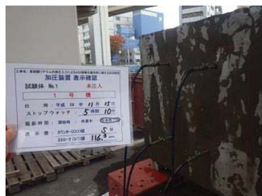
写真-4 内部圧入状況
