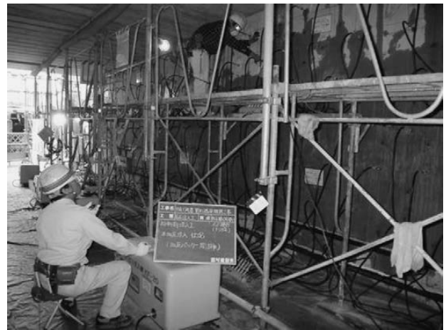
図15 本注入工 (油圧式圧入装置)
