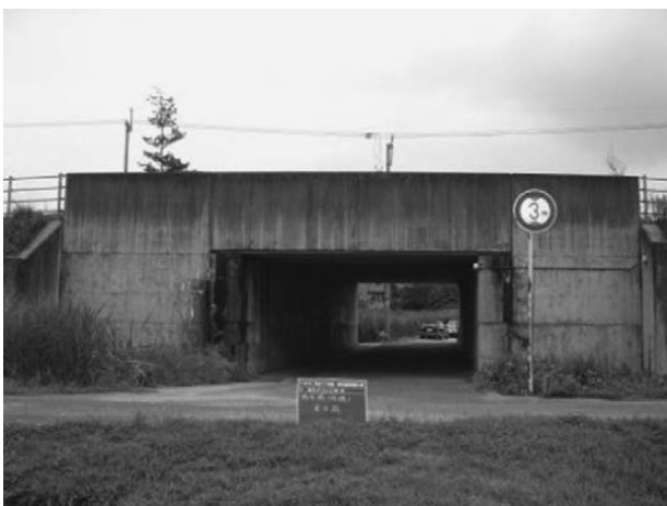
図1 対象橋梁全景
