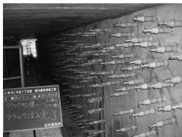
図11 表面漏出防止（ひび割れ注入工）
