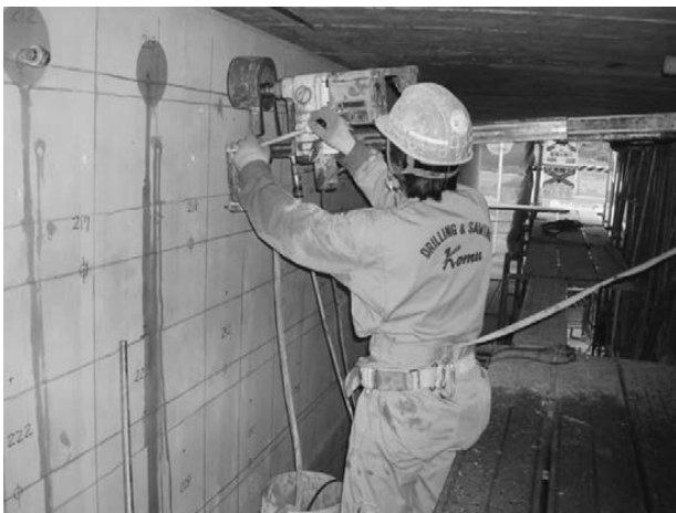
図13 削孔工 (ダイヤモンドコアドリル φ20mm)
