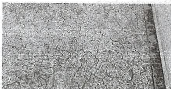
A部の拡大(鉄筋コンクリート床版上面)
