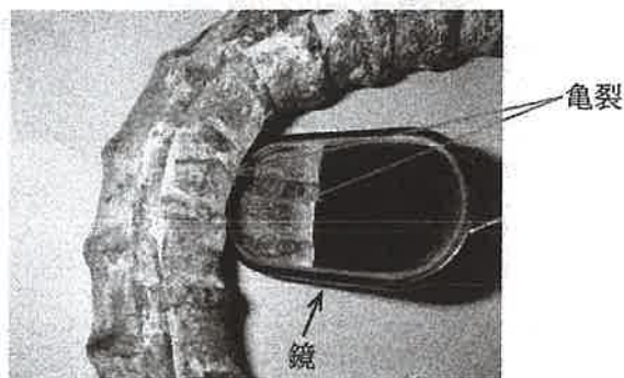
写真1 曲げ加工部の亀裂
