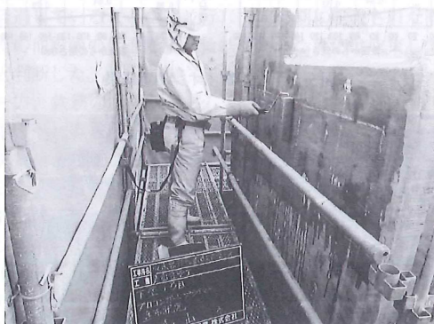
写真一八 表面含浸工
