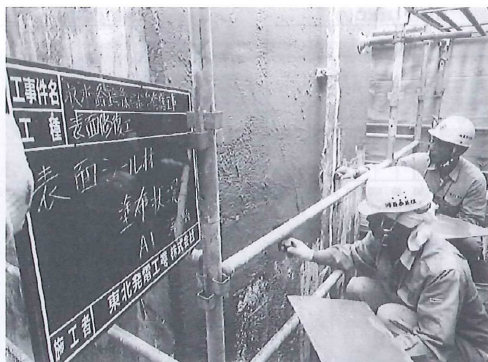
写真一六 表面修復工
