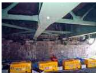
橋台のASR補修事例
