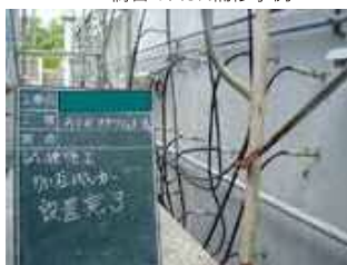
擁壁のASR補修事例
