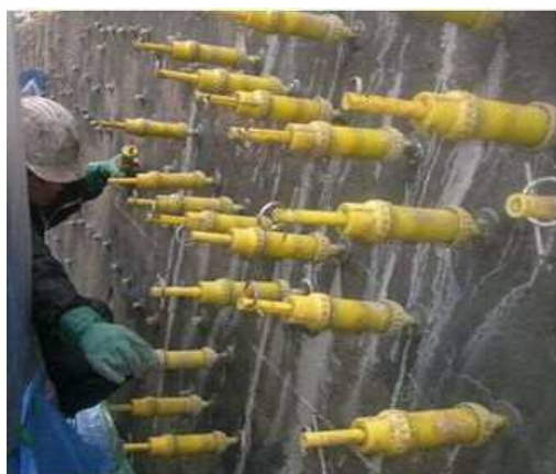
図 4-2 表面漏出防止工(ひび割れ注入工)
