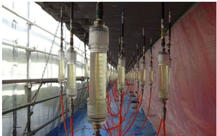
図 1-2 施工状況の例
