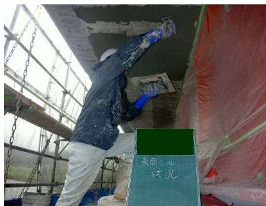
図 4-3 表面漏出防止工(表面シール工)
