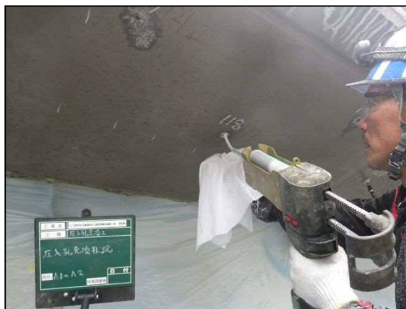
図 4-8 圧入孔充填状況(エポキシ樹脂)
