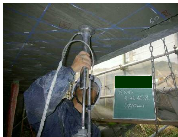
図4-6 削孔状況(ダイヤモンドコアドリル)
