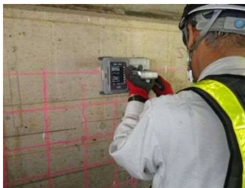
図 4-5 鉄筋探査状況
