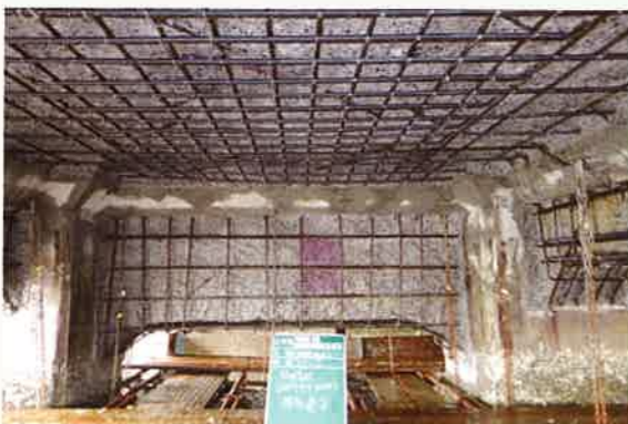
防錆処理完了
