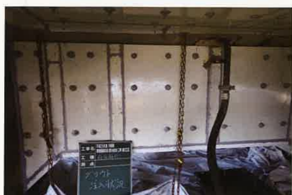
グラウト注入
