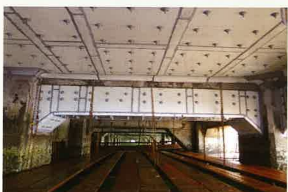
グラウト注入完了
