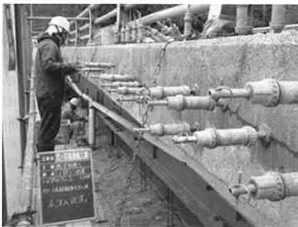
写真3 ひび割れ注入工法の施工状況
