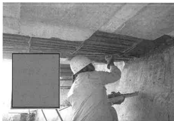
写真4 断面修復工法の施工状況
