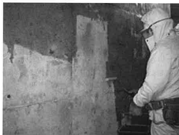
写真1 表面含浸工法の施工状況
