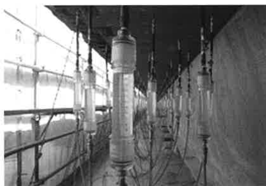
写真5 内部圧入工法の施工状況
