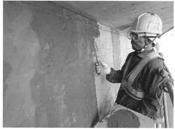
写真2 表面被覆工法の施工状況
