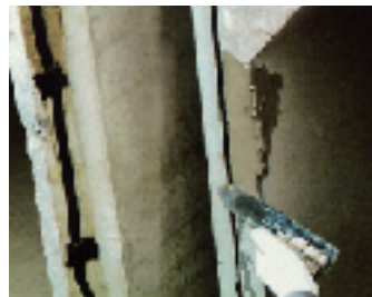
欠損部分を処理
