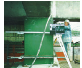
橋脚耐震補強工事
