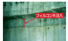
逆打ちモルタル工事
