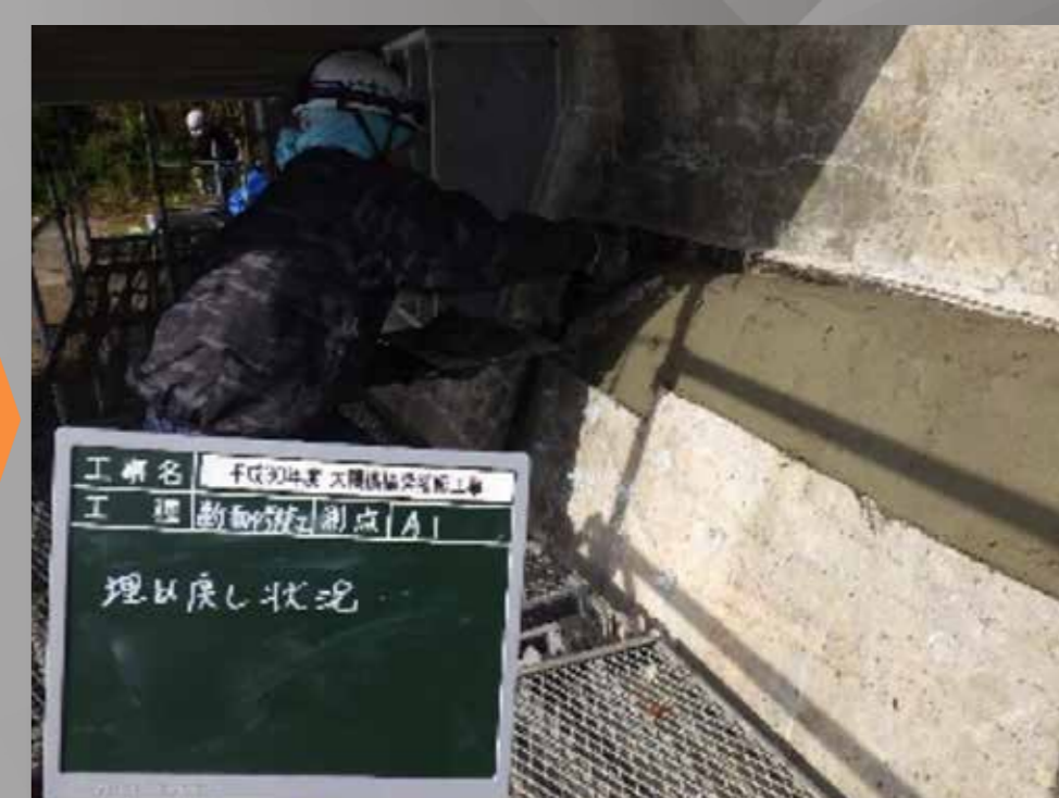
④断面修復
