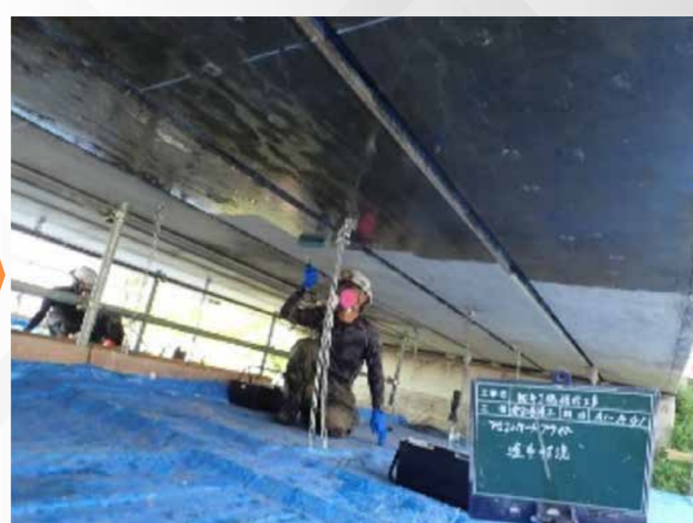
②亜硝酸リチウム系含浸材塗布
