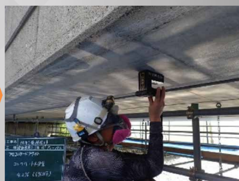
③コンクリート表面水率測定
