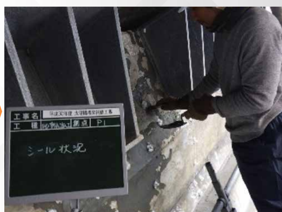
②ひび割れシール
