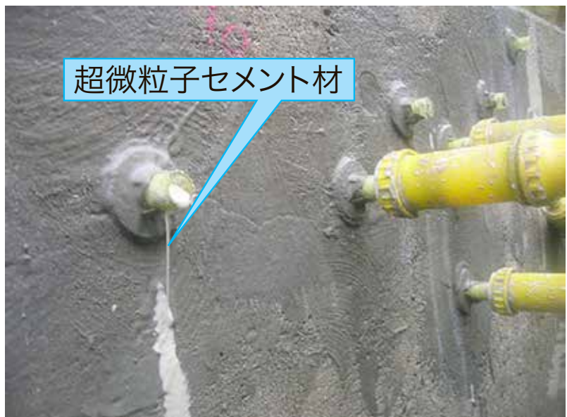
超微粒子セメント材注入状況
