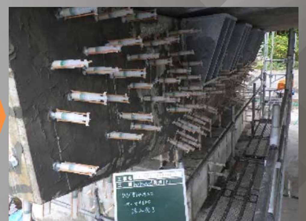
④超微粒子セメント本注入
