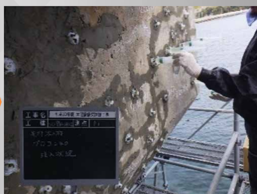
③亜硝酸リチウム先行注入
