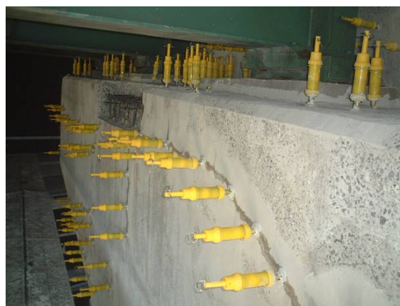
図 3-14 ひび割れ注入工法の施工状況
