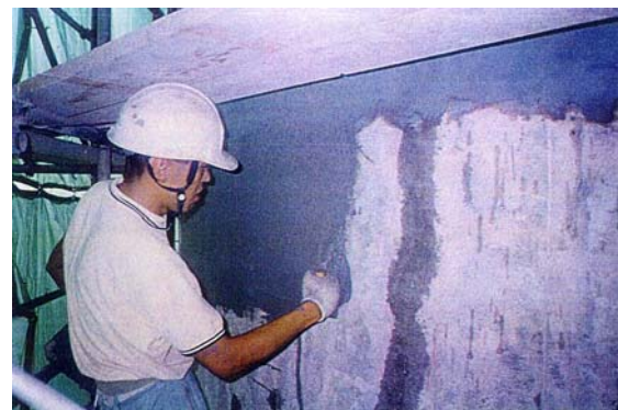
図 3-12 表面被覆工法の施工状況
