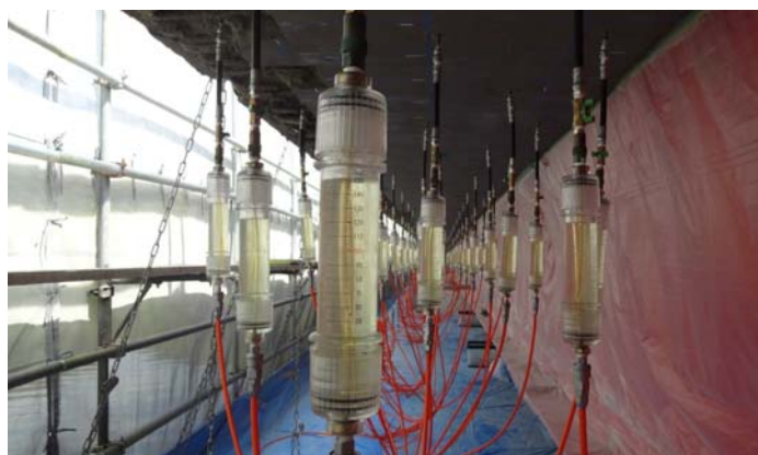
図 3-16 内部圧入工法の施工状況
