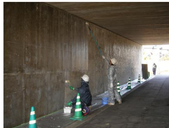
図 3-10 表面含浸工法の施工状況
