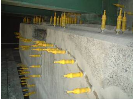
リハビリシリンダー工法施工状況
