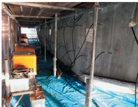
写真-1 施工状況
