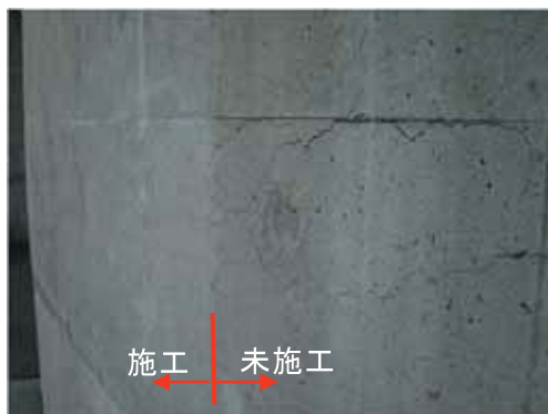
図-6 施工境界付近の状況
