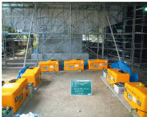
写真-2 海田高架橋施工状況
