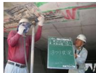
劣化部の除去
