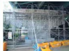
橋脚(はり部)のASR補修事例
