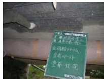
鉄筋の防錆処理
