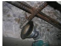
鉄筋のケレン
