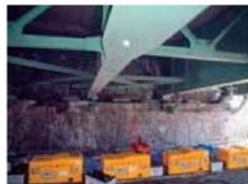
橋台のASR補修事例
