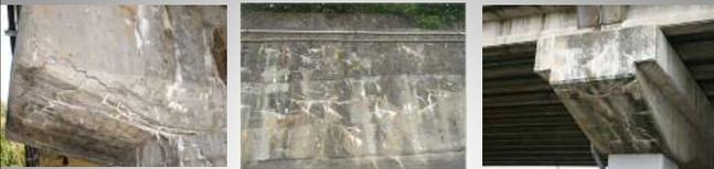
ASRにより劣化したコンクリート構造物の変状事例
