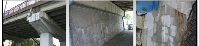
ASR補修後に再劣化したコンクリート構造物の事例
