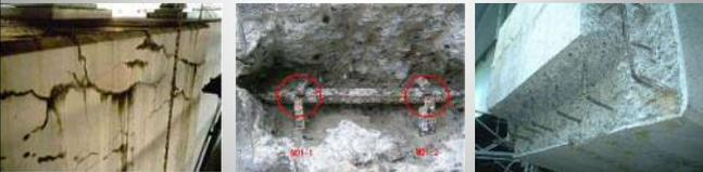
ASR劣化により鉄筋破断を生じたRC橋脚の事例
