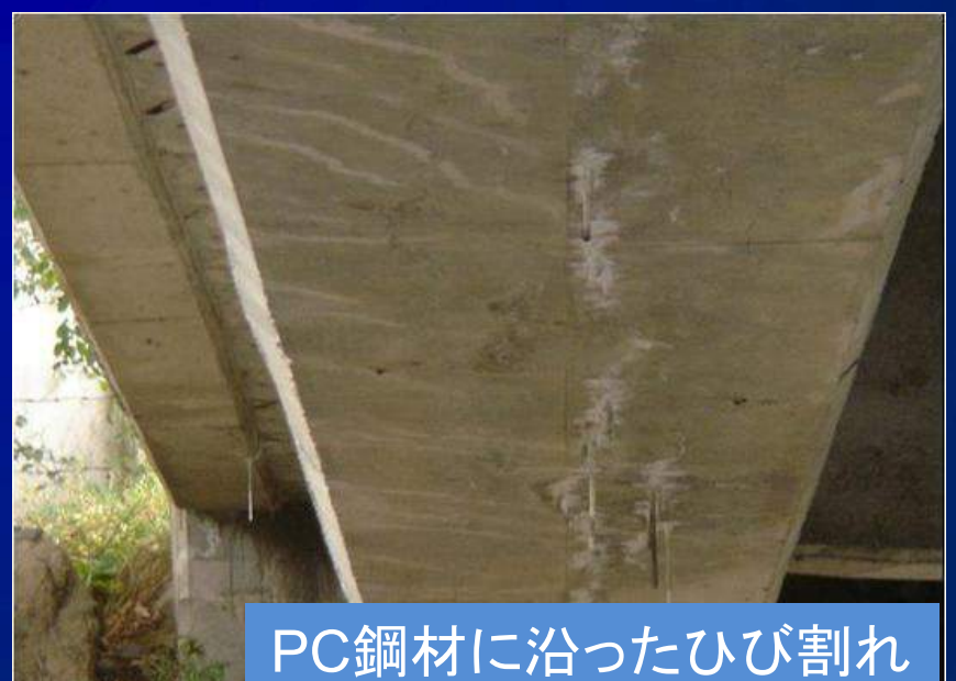
水平方向ひび割れ
