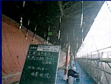
⑥加圧パッカーの設置
