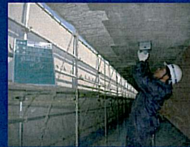
④鉄筋探査工
