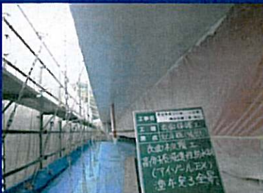
⑪施工完了
