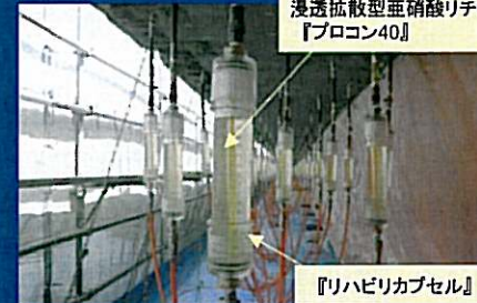
⑧内部圧入工
