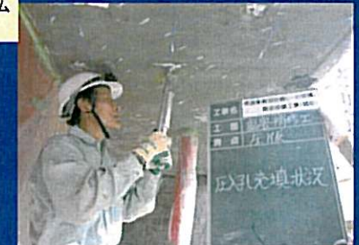
⑨圧入孔充填工
