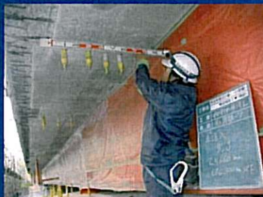
②表面漏出防止(ひび割れ注入)
