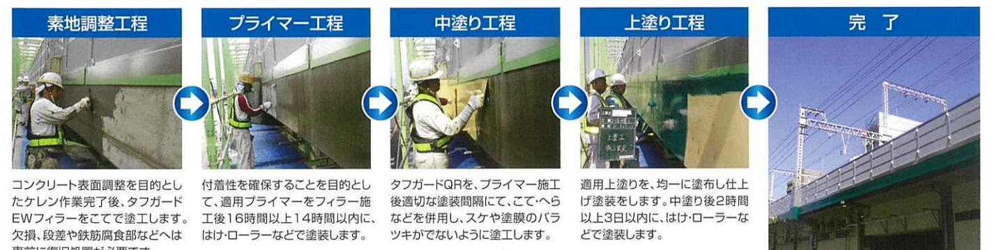
コンクリート表面調整を目的としたケレン作業完了後、タフガードEWフィラーをこてで塗工します。欠損、段差や鉄筋腐食部などへは事前に復旧処置が必要です。
