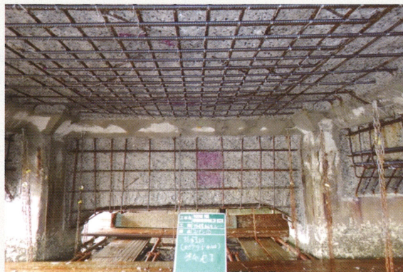
下地処理完了
