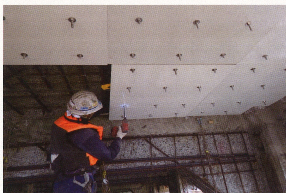
GMP板組立て(ネット締付加工)
