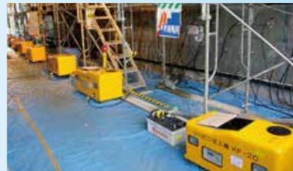
油圧式高圧注入『ASRリチウム工法』
