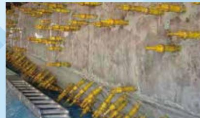
ひび割れ低圧注入『リハビリシリンダー工法』
