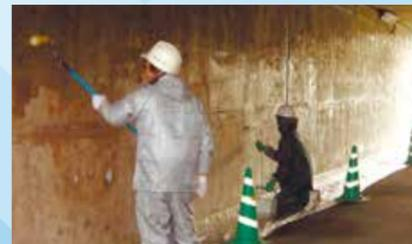
表面含浸工法『プロコンガードシステム』
