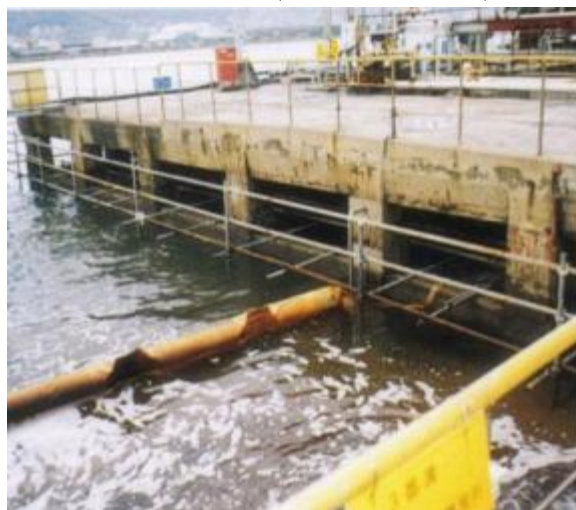
施工前(全体像)
