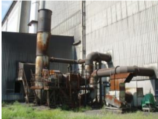
屋外排気設備 施工前
