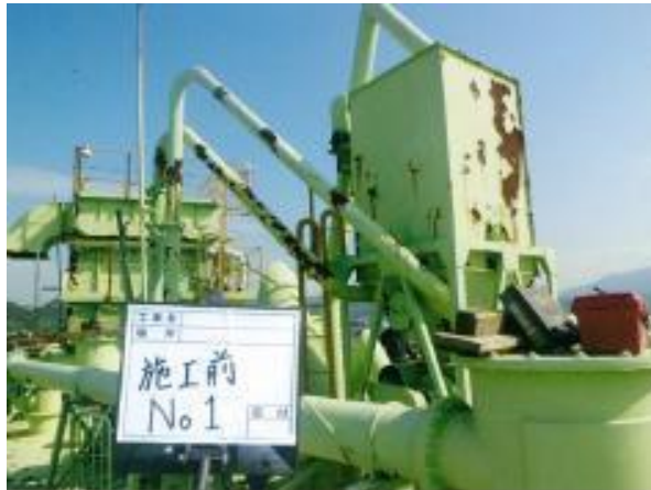
セメントサイロ 施工前
