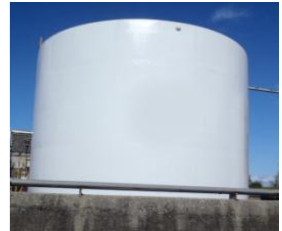
化学工場 施工後
