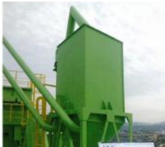
セメントサイロ 施工後
