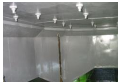
天井部 GFプロテクト施工
