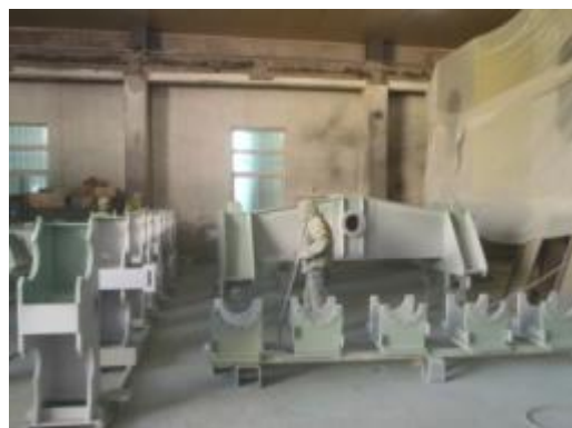
上塗材 塗装状況
