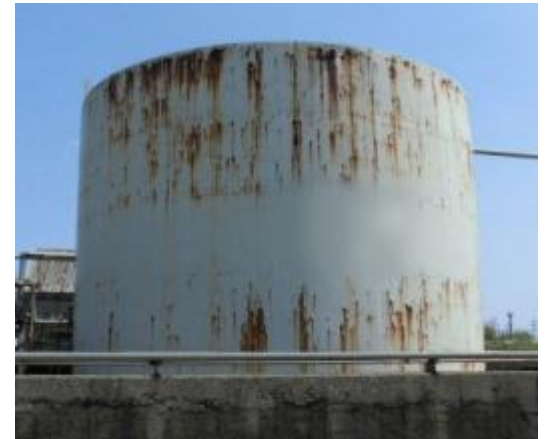
化学工場 施工前
