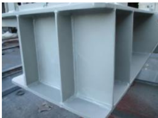
下塗材塗布状況
