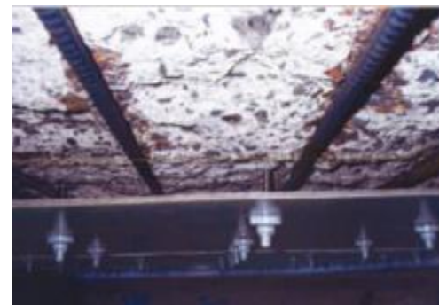
埋込型枠加工取付(GMP板=7mm)
